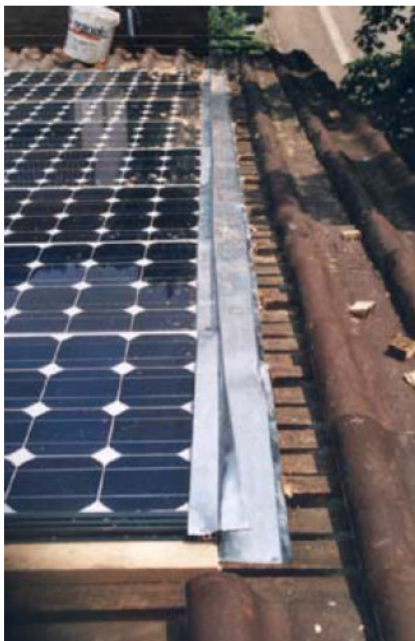
Pose des solins d'étanchéité latéraux
