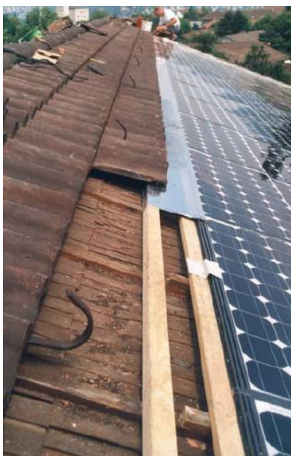
Pose de la bavette supérieure
